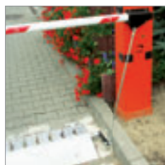
Mechaniczne połączenie kolczatki ze szlabanem.
